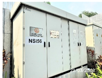
Ring Main Unit ของการไฟฟ้า
